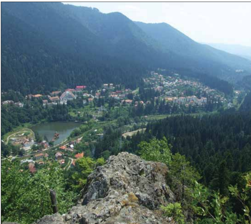
Figura 2. Defileul Oltului la Băile Tușnad. Efectul cumulat al diferitelor tipuri de bariere, zona construită, drum național, cale ferată și curs de apă.
