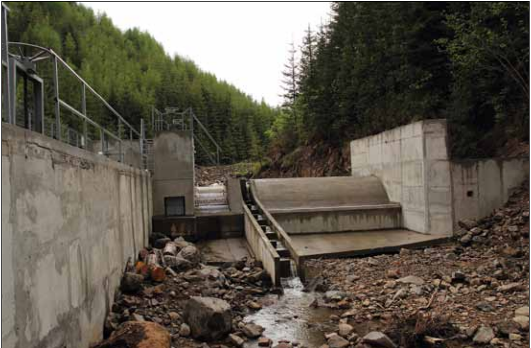
Figura 10. Microhidrocentrală la limita sitului Natura 2000. Debit salubru neasigurat.
