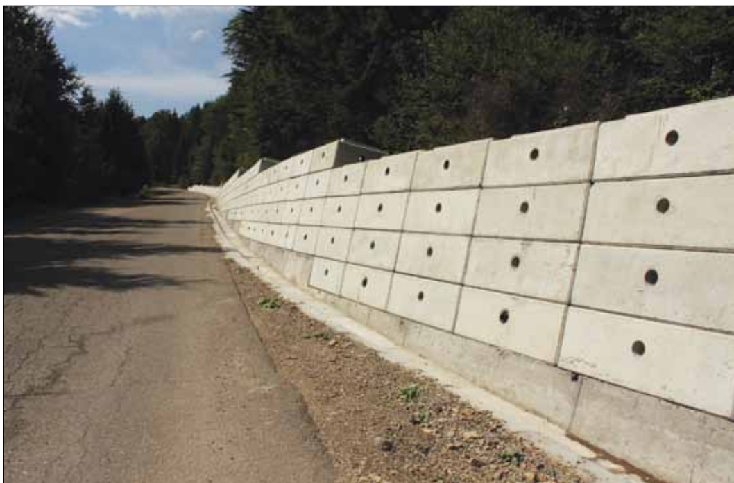
Figura 14. Parapet din beton lângă DN 2D, barieră absolută pentru urs.
